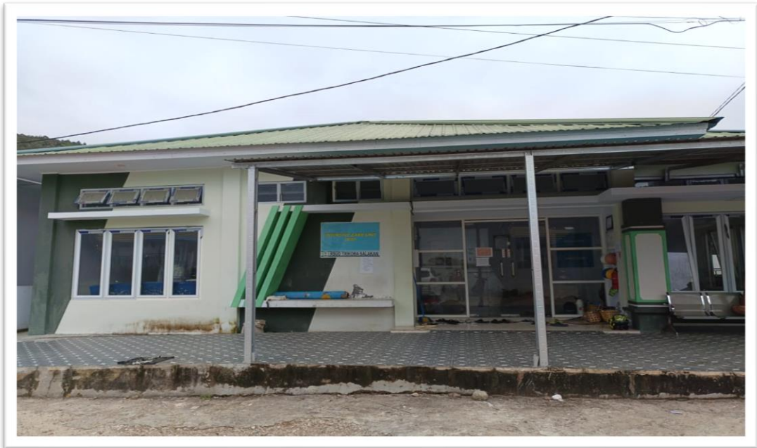
Gedung ICU/ICU RSUD Trikora Salakan
