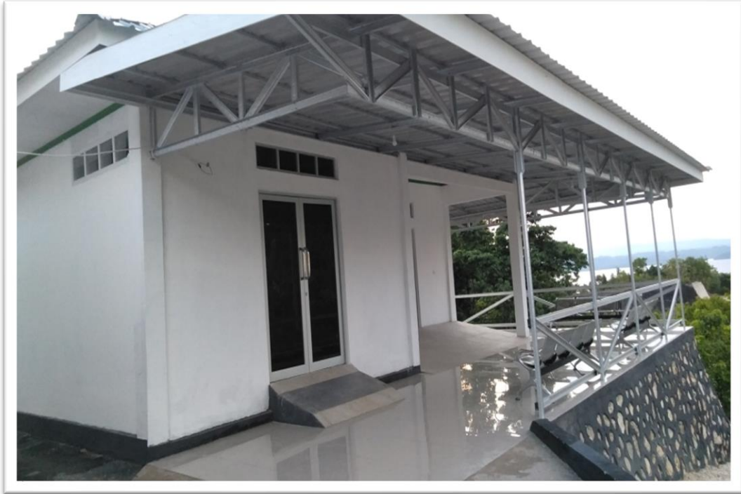
Gedung Pemulsaran RSUD Trikora Salakan
