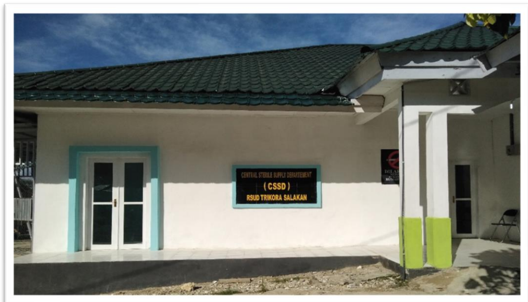
Gedung CSSD RSUD Trikora Salakan
