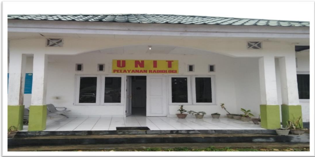
Gedung Radiologi RSUD Trikora Salakan
