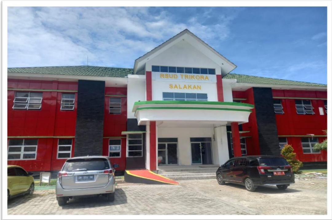
Gedung Administrasi RSUD Trikora Salakan
